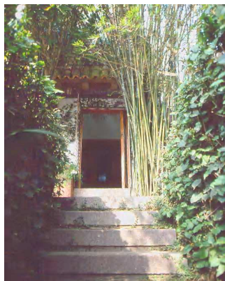
ESCALERA HACIA LA CALLE
