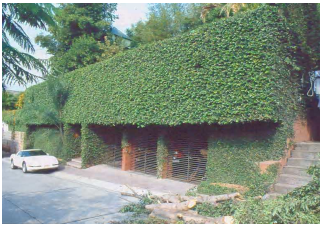
FACHADA PRINCIPAL HACIA LA CALLE
